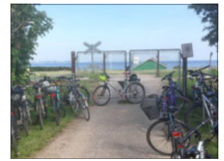
Det er dette hegn ved Rolighedsvej i Risskov, som gentagne gange er brudt op. Foto: Aarhus Letbane
